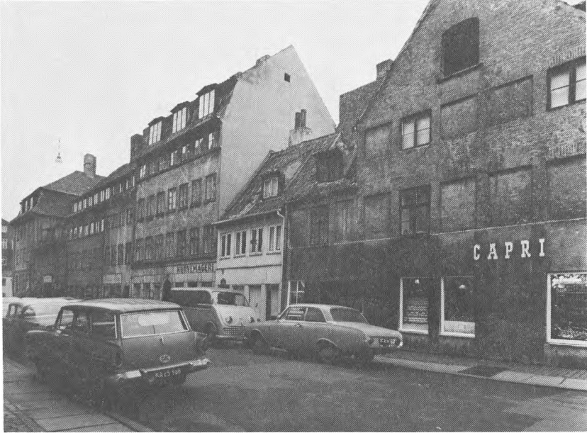
Sofiegade 7. Forhuset. Matr. nr. 359.
