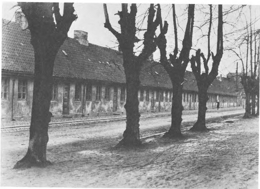
Holms Huse, Langebrogade. Matr. nr. 202 A og 202 B.
