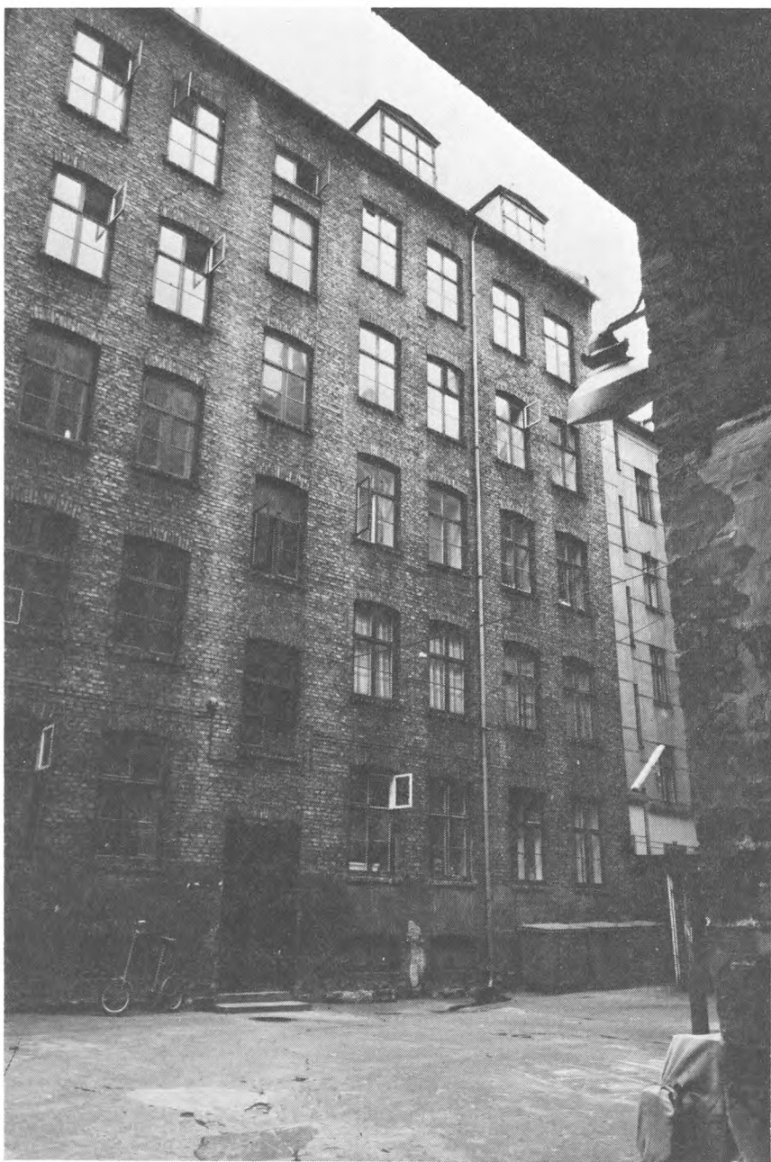
Vesterbrogade 117. Sidehus. Matr. nr. 43 D1 (i 1943 ændret til matr. nr. 43 i).
